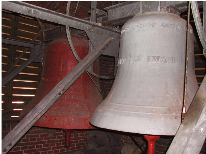
Die Weule-Eisenhartgußglocken von 1951. Links in rotem Anstrich die 'g'-Glocke, rechts in grau die b''-Glocke.
